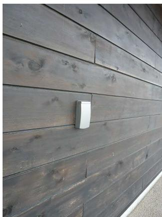
再塗装方法：基本的に塗膜を剥離しないで、表面の汚れ落とし、軽くサンディングした後、しっかり定着している塗膜の上に全体を1～2回上塗りする。
